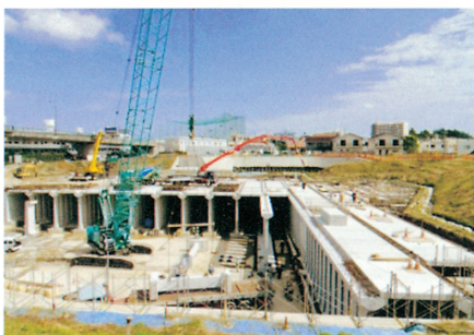
施工状況（全景）
