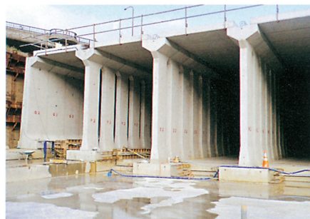
底版コンクリート打設
