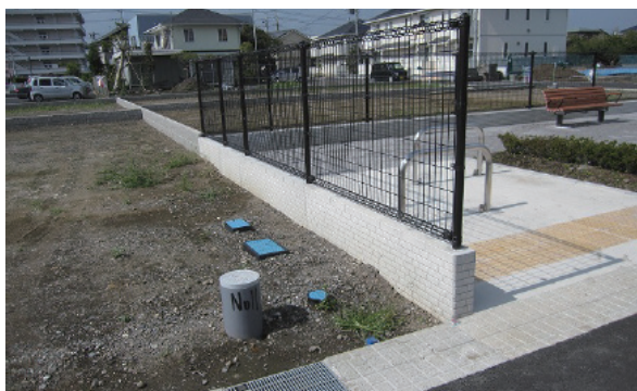
○栃木県宇都宮戸祭町 宇都宮市戸祭3丁目住宅団地造成工事
