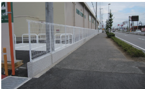
○栃木県宇都宮市野高谷町 プライムマート テクノ店新築工事
