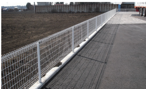
○栃木県鹿沼市南上野町 ファミリーマート鹿沼南上野店新築工事
