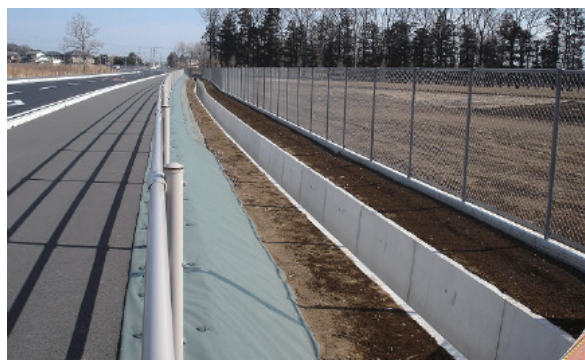
○栃木県小山市出井 葉たばこ研究所 法定外公共物付替え工事
