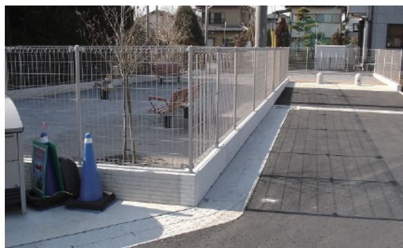
○栃木県下都賀郡壬生町安塚 安塚住宅団地 造成工事
