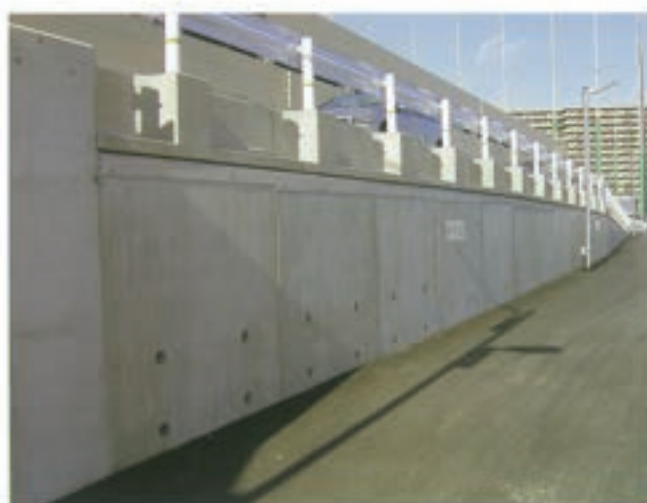
プレキャストL型擁壁直上
