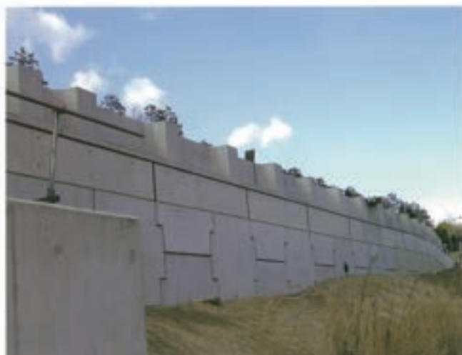
補強土壁直上
