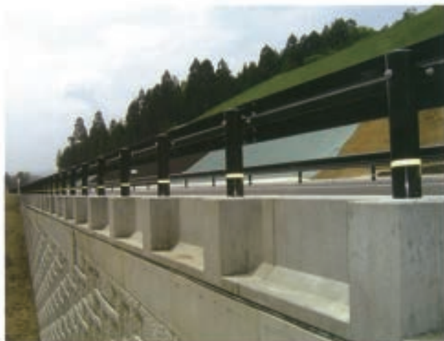
補強土壁直上
