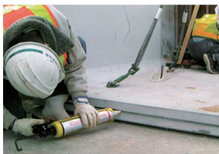
② 挿入孔へ充填材の注入
