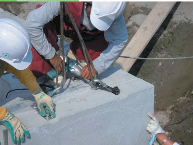
本体とパネル及びパネル同士を連結します。仮止めをするまでは吊金具を外さないようにして下さい。
