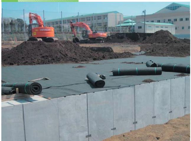
製品上面に吸出防止シートを敷き、土を埋戻します。
