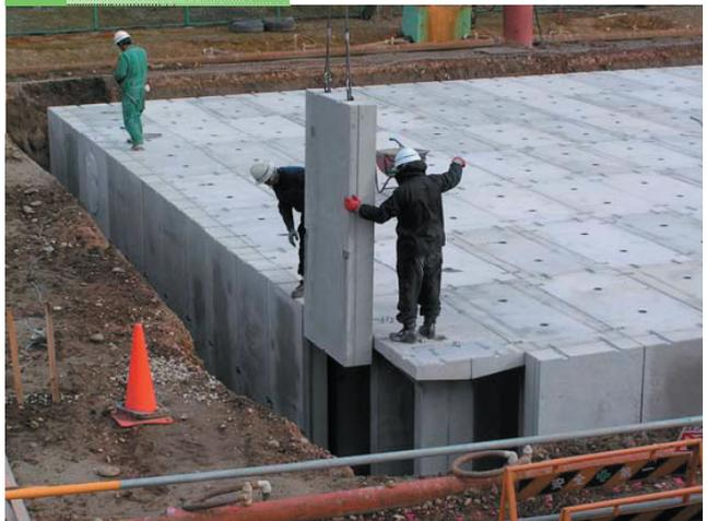
漏水防止用の止水パッキンを貼り付け、パネル製品を据え付けます。
