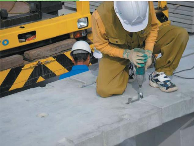
連結プレートを用いて本体製品相互を連結します。インパクトレンチがあると施工が容易です。
