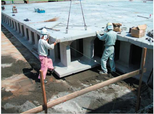
敷モルタルを用いて高さの調整を行いながら、本体製品を据え付けます。
