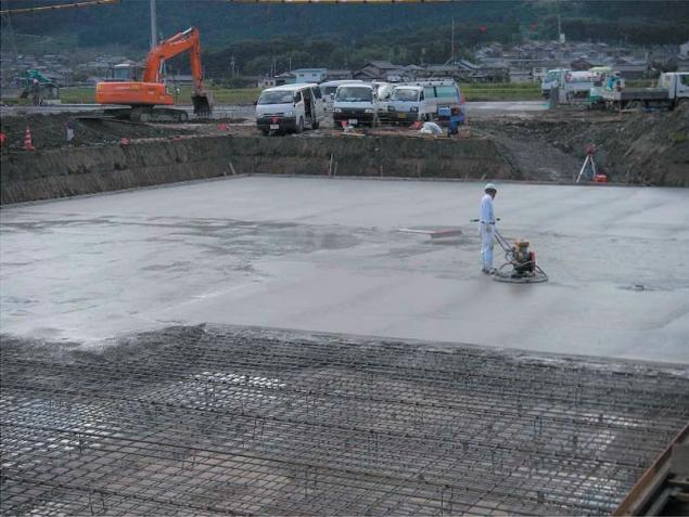
コンクリートの均し面を精度良く仕上げると、製品の据付が容易になります。
