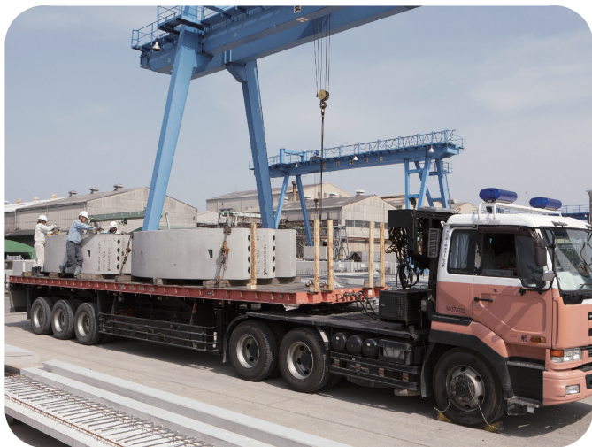
運搬（アーチ部材）
