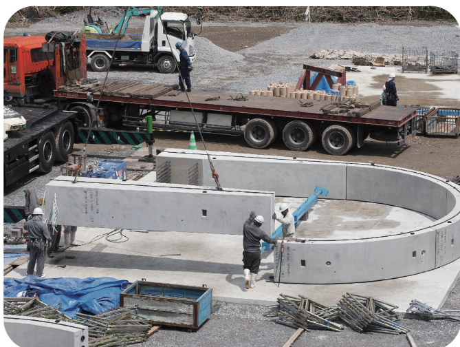
配置・組立（地組み施工）
