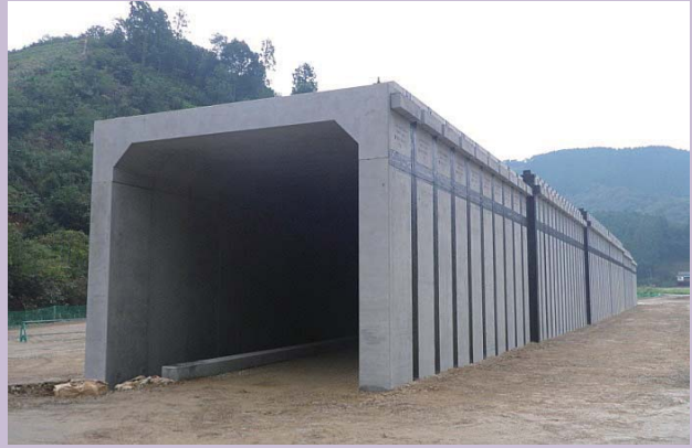
〈宮崎県〉東九州自動車道(県境～北川間) 発注：国土交通省 九州地方整備局 延岡河川国道事務所 仕様：【B5900×H6400 延長87m】
