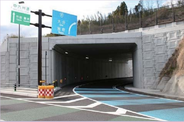
〈大分県〉国道57号 犬飼千歳道路(犬飼IC) 発注：国土交通省 九州地方整備局 佐伯河川国道事務所 仕様：【B10300×H6200 延長30m】(曲線施工R=30)
