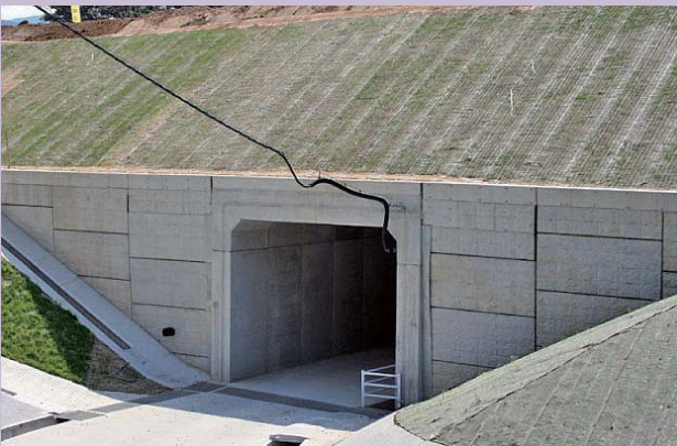
〈佐賀県〉国道497号 谷口地区改良工事 発注：国土交通省 九州地方整備局 佐賀国道事務所 仕様：【B5000×H5100 延長70m】
