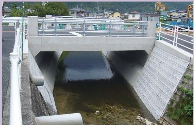
〈福岡県〉県道56号 福岡早良大野城線(内野橋) 発注：福岡市役所 仕様：【B7000×H3500】(斜角71度)
