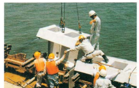
■製品布設状況
