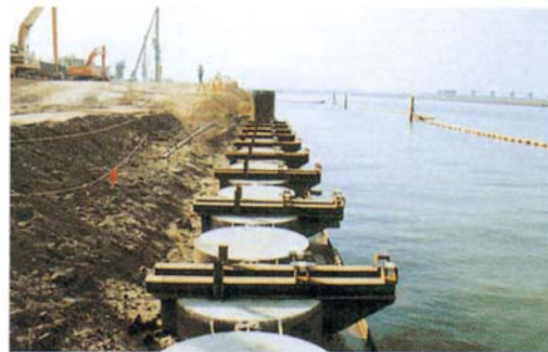
2. 受台（H鋼）設置状況（溶接固定）
