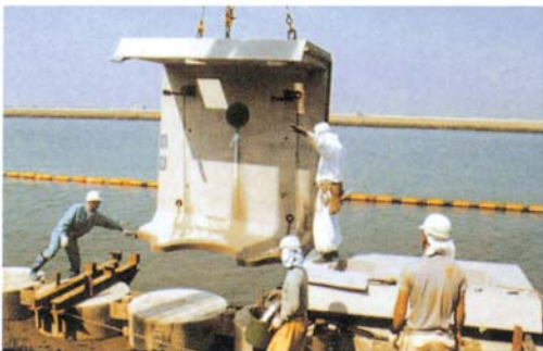
3. 製品吊り上げ状況
