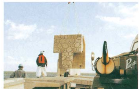
■ベースブロック（特殊）吊上げ状況
