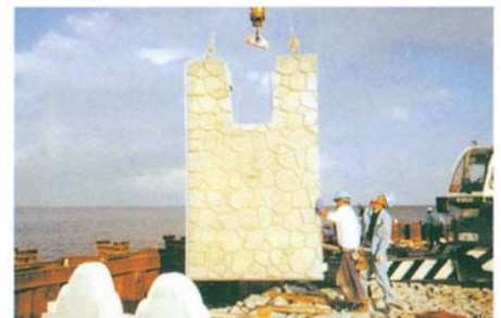
■笠コンウォール（Ⅲ型）吊上げ状況
