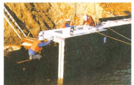
■ 製品布設状況
