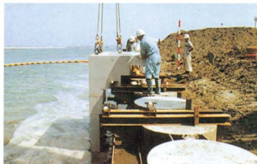
4. 製品布設状況
