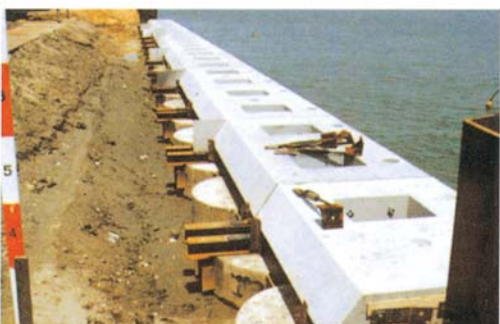
5. 布設後状況－コンクリート打設
