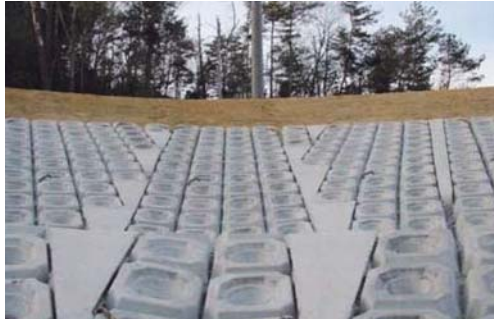
現場打ちコンクリートによる処理
