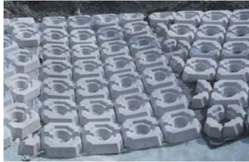
間詰めブロックによる処理
