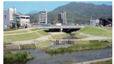
施工後3ヶ月経過
