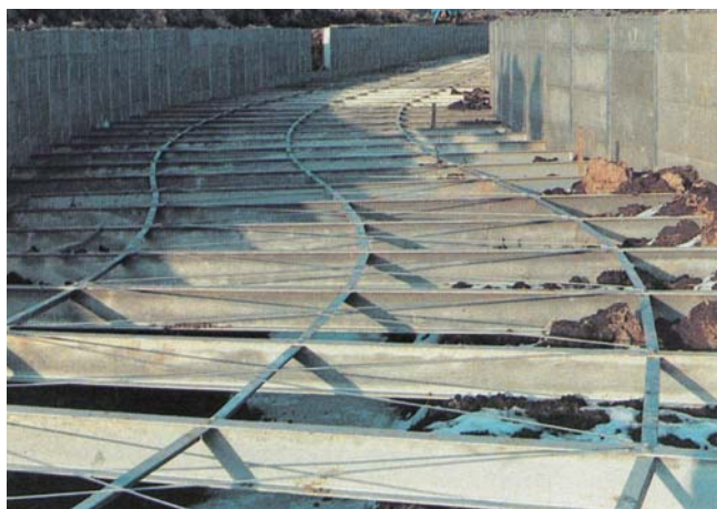
岩手県花泉町外谷地排水路 (両磐土地改良事業所) B5.5m×H1.3m 3ヶ所所固定材及びタイロット使用 (S57年施工)
