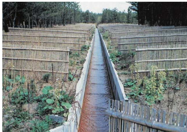
青森県むつ市防災林造成工事 (下北地方農林事務所) B1.0m×H1.0m フィルター側板を使用し地下水の集排水利用 (S58年施工)
