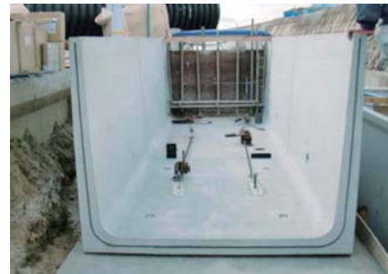
⑥据付完了
