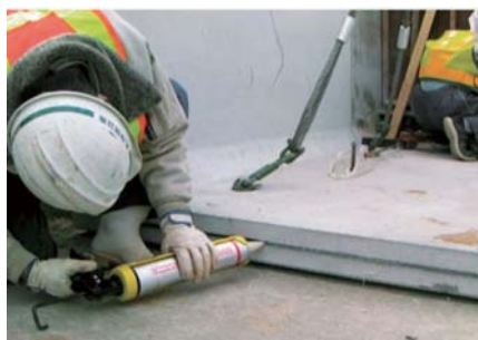
②挿入孔へ充填材の注入
