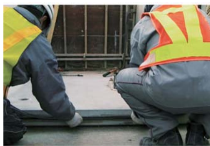
④ジョイントゴムの取付
