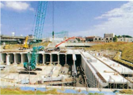
施工状況 (全景)
