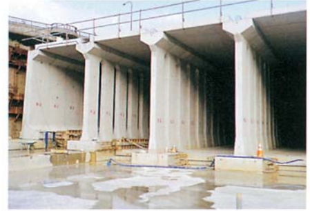
底版コンクリート打設
