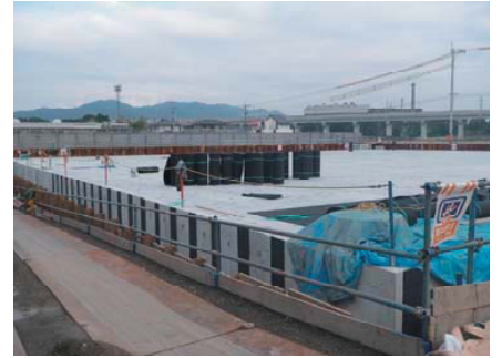
民間工事：熊本県宇土市
