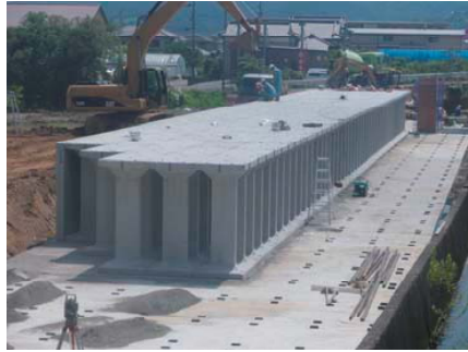
民間工事：熊本県天草市
