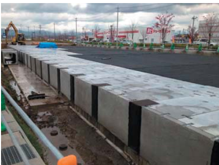
小松市沖周辺土地区画整理組合：石川県小松市
