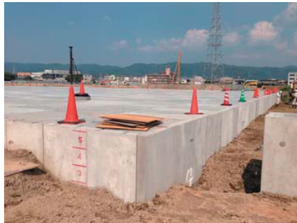
民間工事：京都府宇治市
