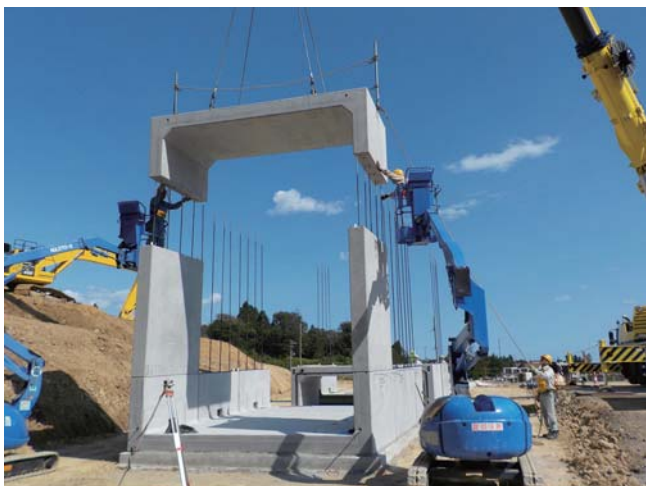
③大谷地区改良工事 サイズ B4000×H4500 L=24m
