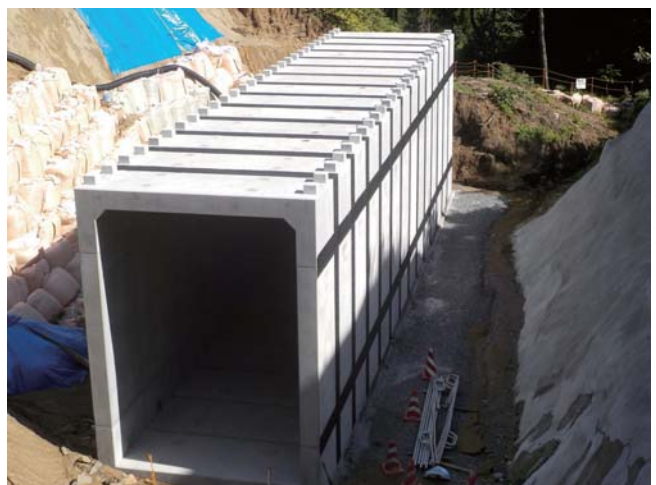
⑥山口第二トンネル追加工事 サイズ B3500×H4900 L=21m
