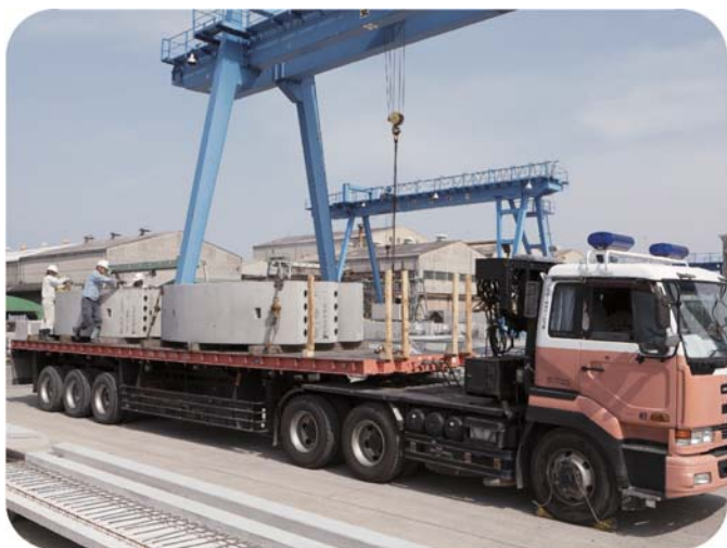
運搬 (アーチ部材)
