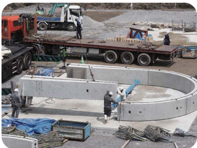
配置・組立 (地組み施工)
