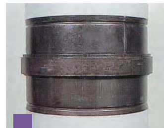
6 油圧ジャッキの取り外し、ジョイント作業完了。
