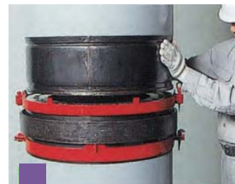
2 上杭と下杭と接合するガイドリングを取付け、上杭を建込む。
