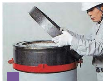
1 内周面に防錆剤を塗布した外リングを下杭に挿入する。
