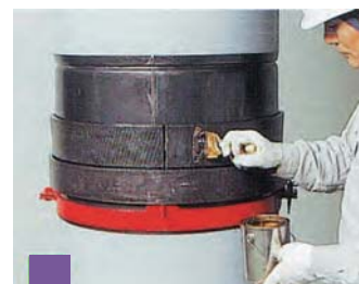
4 取り付けられた内リング外周面に防錆剤を塗布する。
