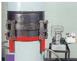
5 外リングを油圧ジャッキで上にスライドさせ、継手を固定させる。
